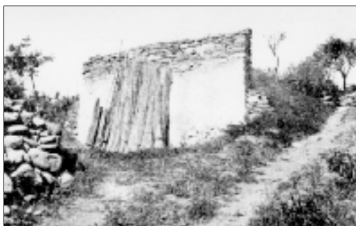
108. ábra. Egyszerű pince Révfülöpön. A pinceajtót az erős napsugárzás ellen nád-kévékkel beárnyékolják. (Szerző felvétele.)
