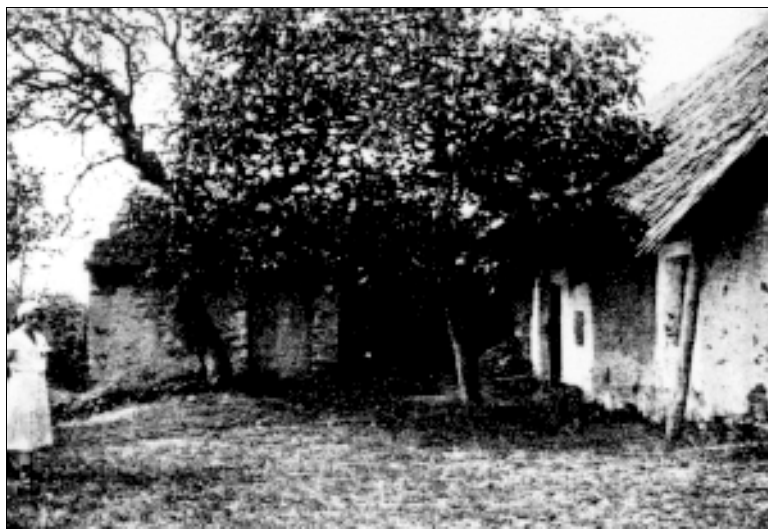
111. ábra. Félszeres és istállós pince Almádi és Alsóörs határánál. A pince messze van a falvaktól, a gazda kénytelen volt kocsin kijárni és ott is éjjelezni, ezért félszerre volt szükség. Ilyen helyen a legtöbb pincének van félszere, istállója. (Szerző felvétele.)
