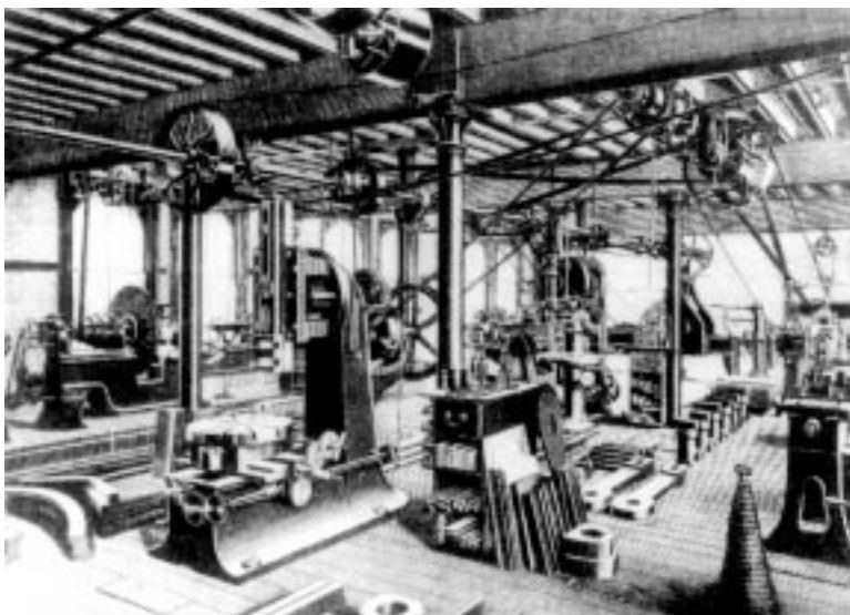
13. ábra A próbatestek kimunkálására alkalmas berendezések Kirkaldy laboratóriumában
