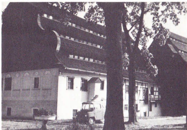
A duszniki (Lengyelország) papírmalom. Jól látható a papír szárításához használt magas padlástér a jellegzetes szellőzőnyílásokkal (fotó: Z. Wasylkowski)
