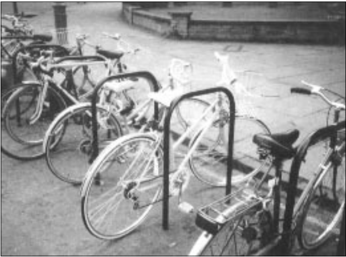
Ezek a támasztókeretek egész Európában beválnak. Minden alapvető követelményt ki-elégítenek. Egy további keresztrúd a talaj felett 0,55 méter magasságban egyes váz-típusok rögzítéséhez hasznos lehet.
