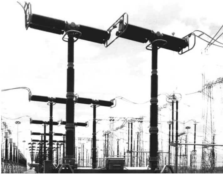
12. ábra. Kénhexafluorid ( \text{SF}_6 ) gázos megszakító, U_n = 420 \text{ kV} , I_n = 4 \text{ kA} , I_{szak} = 80 \text{ kA} (SIEMENS)
