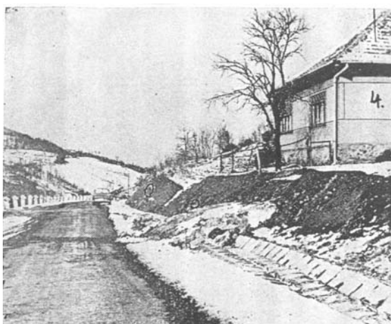
3. ábra. Támfal hibás tervezése és tönkremenetele
