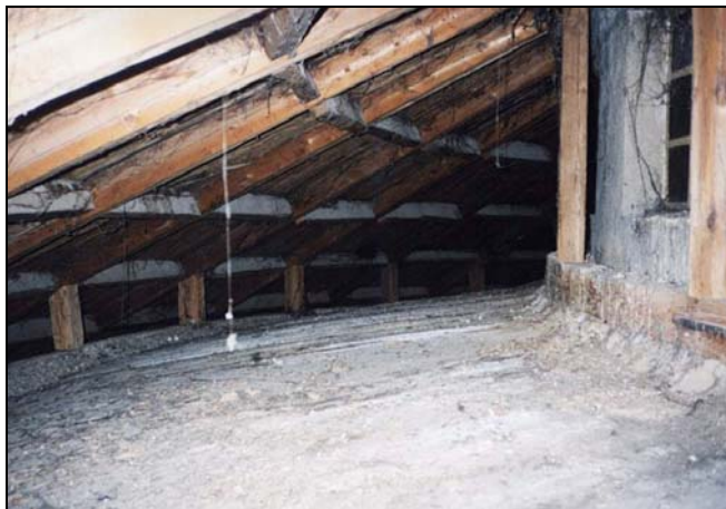
20. ábra. A tambur beágyazása a tetőzetbe
