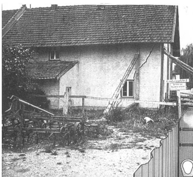
2. ábra. Sarok süllyedés hatása az épület tartószerkezetére
