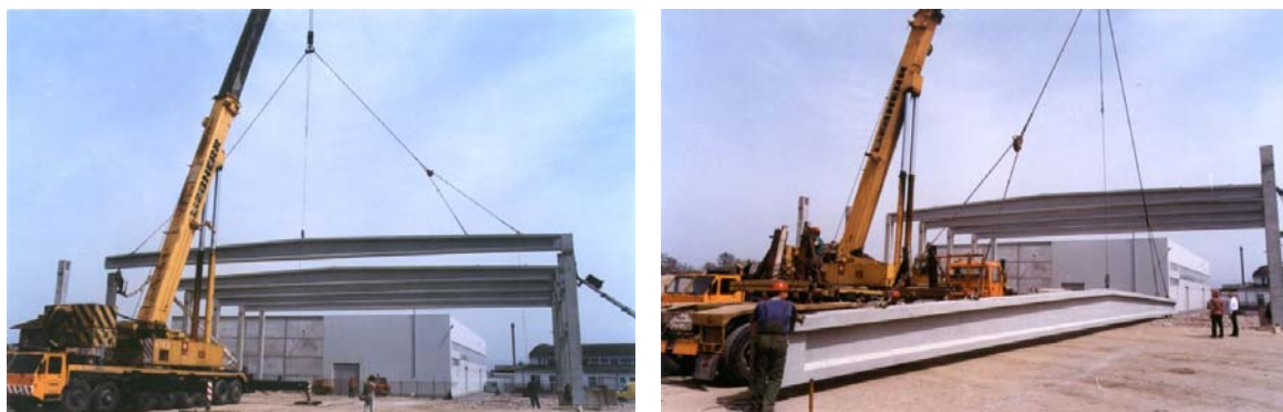
3. ábra. 36 m fesztávolságú feszített vb. gerendák Szófiában (előzmény: Dachslér Alsdorf (D); mindkettő Plan 31 H EC2 számítással)
