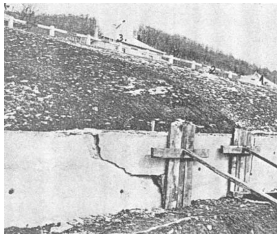
3. ábra. Támfal hibás tervezése és tönkremenetele
