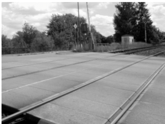
3. kép BODAN útátjáró burkolati rendszer kétvágányú vasúti pályában
