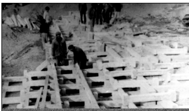
26. ábra Küszöbgát szerelés közben a Sebes-Körösön
