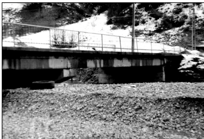
5. ábra A nagymennyiségű lerakott hordalék, a híd keresztmetszetét veszélyezteti
