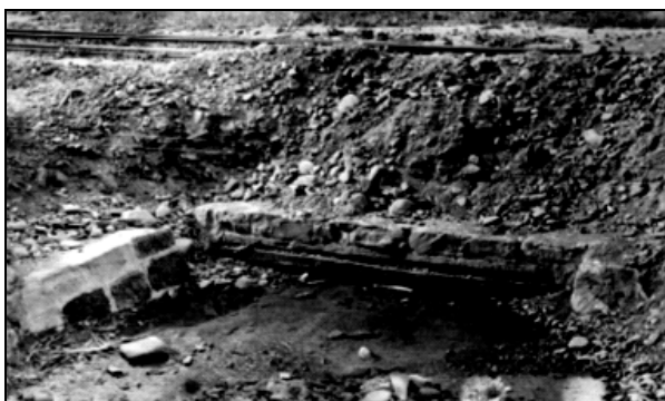
18. ábra Egy vasúti átereszt és a vasúti pálya hordalékkal betömve és eltakarva. Az átereszt tisztítása folyamatban
