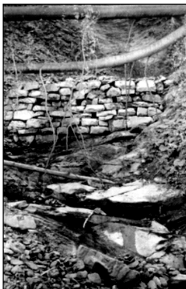
17. ábra Egy száraz falazatból kialakított torrens gát; egy nagyon aktív működéssel, és katasztrófális eredménnyel a vasúti pályára (18. ábra)
