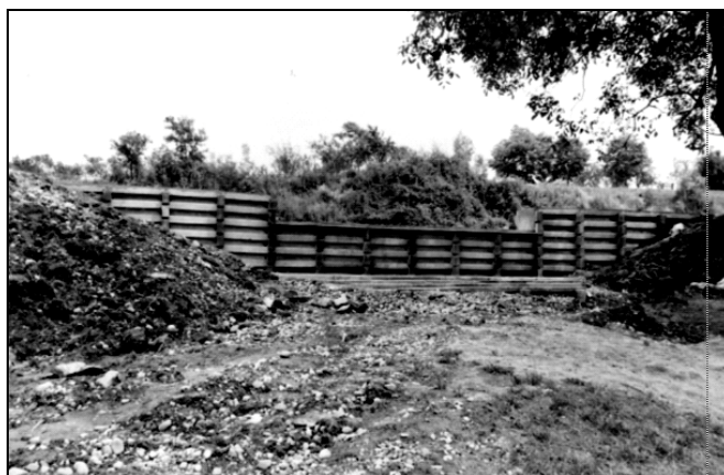
22. ábra Torrens gát előregyártott vasbeton elemekből, az utolsó simítások előtti kivitelezésben
