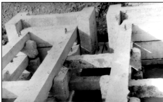
27. ábra A nehéz- és könnyűelemek kombinációja a küszöbgát központi részén
