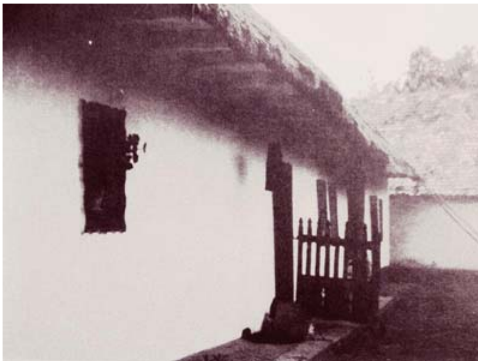
1. sz. kép: Fő út 55. sz. lakóház. (Nagypaliék.) Épült 1880-ban. Kőfal, mestergerenda, szabadkémény. A képet 1965. V 29-én Bakó Ferenc készítette.
