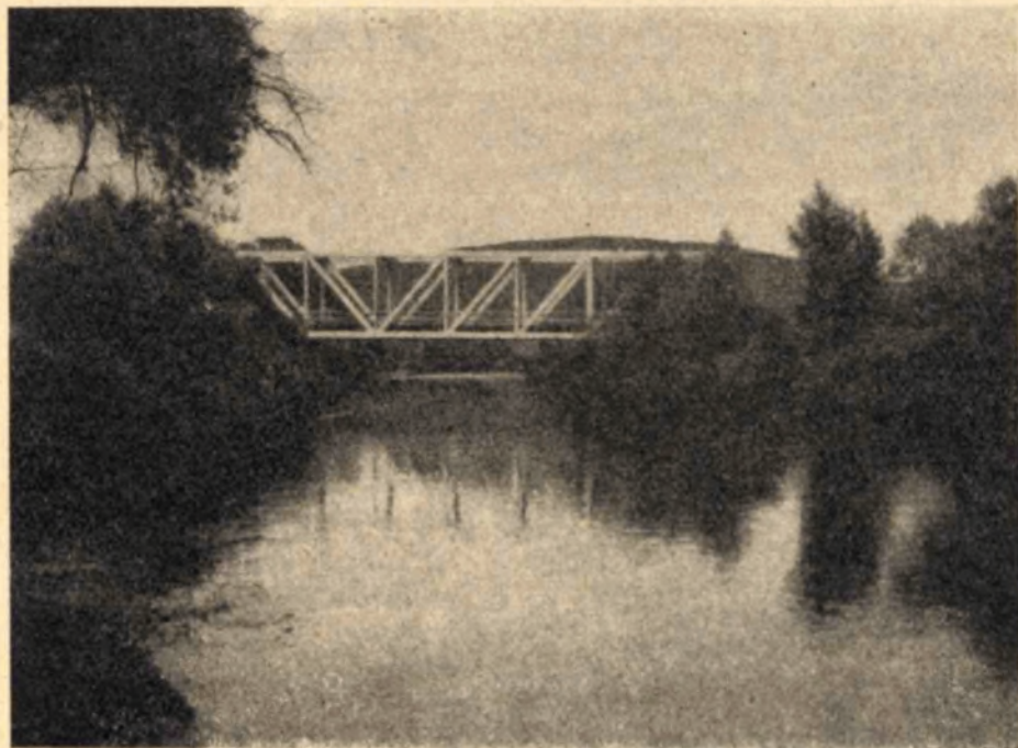
45. kép. Vasúti híd a Sajón.
