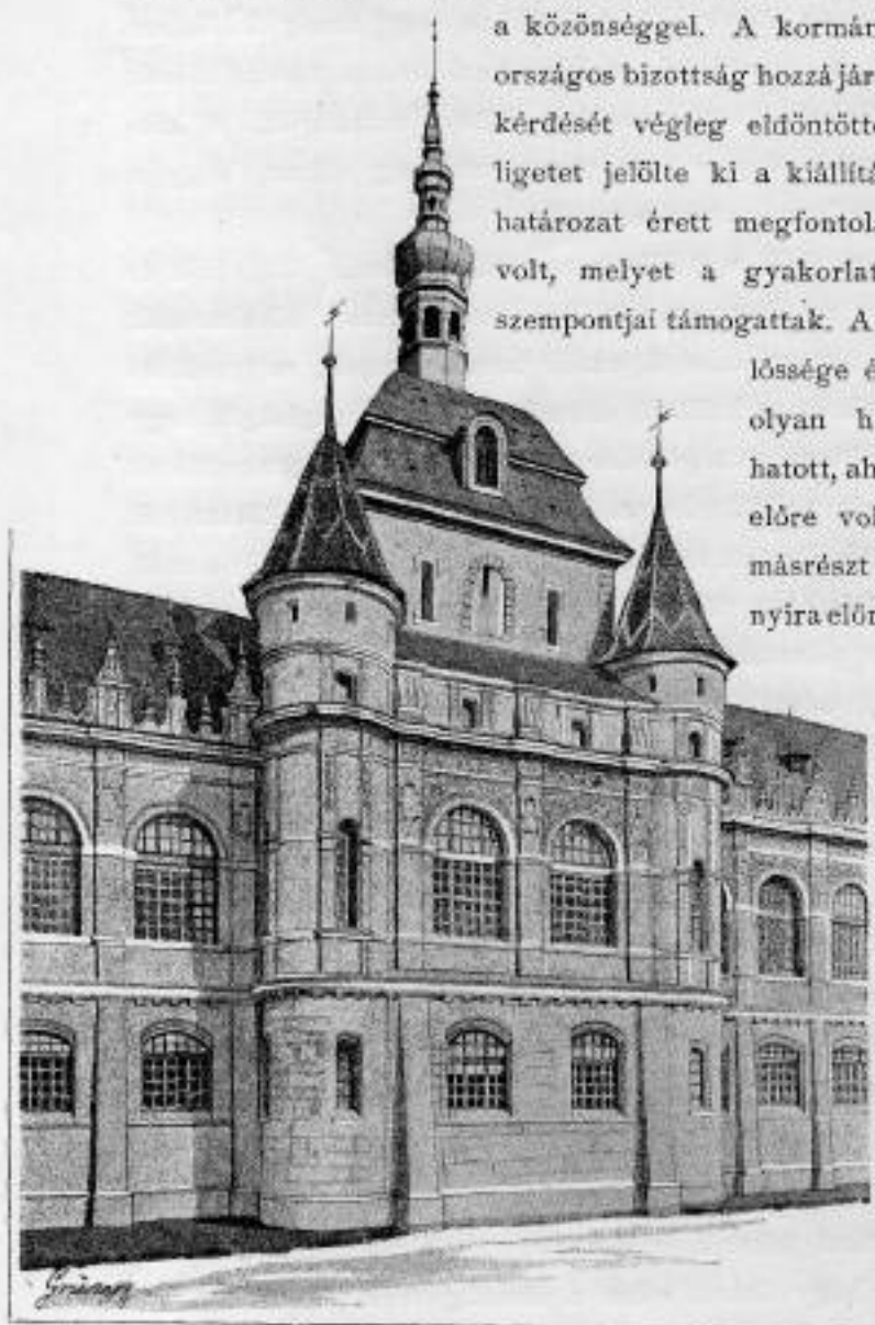
A rendezés épületek hátsó homlokzata.
