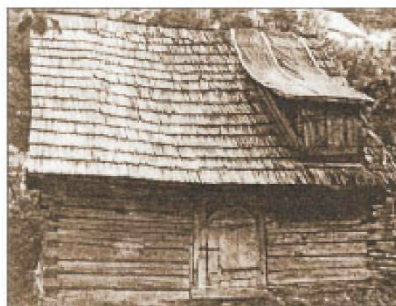
A 65. számú házzal szemben álló gazdasági épület (fotó 1975-ből)
