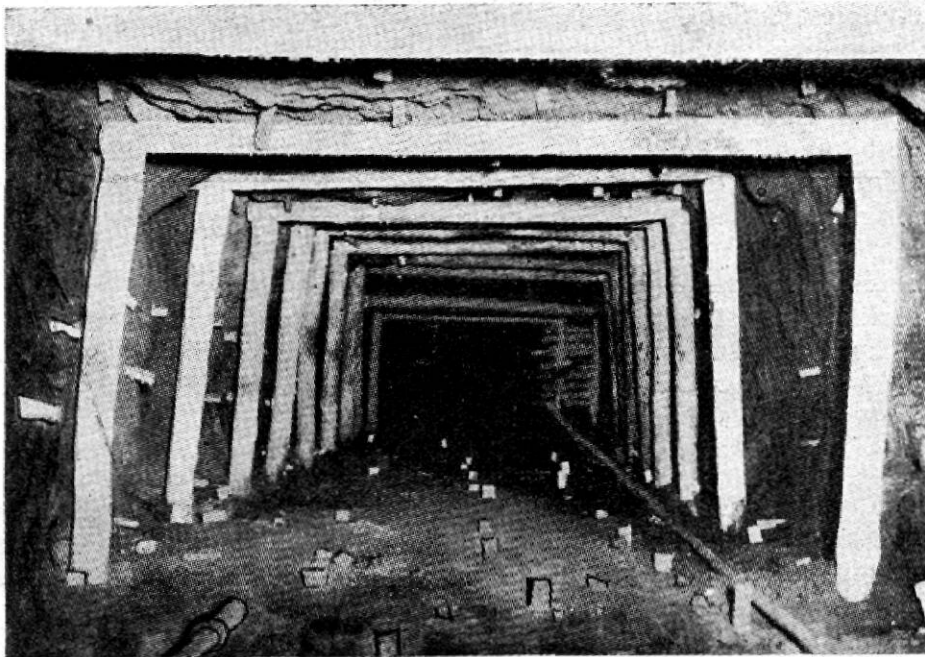
14. ábra. Pillérrobbantó fúrólukak egy osztószinti fejtésben
