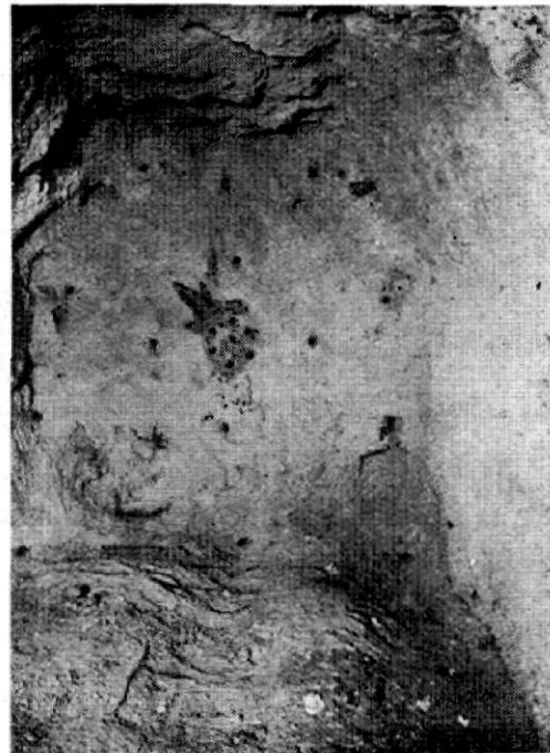
13. ábra. Hengeres morzsoló betörésre lefűrt vágjég
