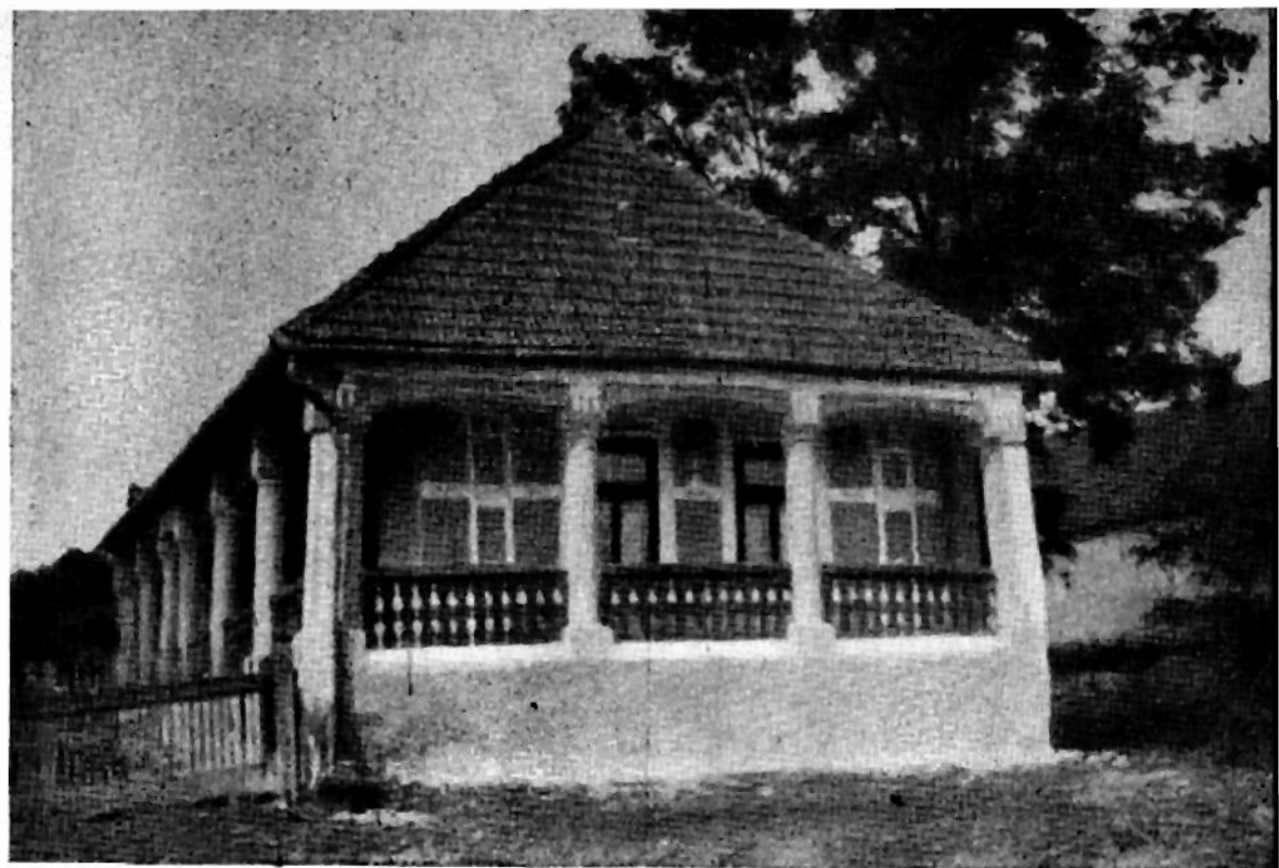
65. Galvácsi tornácos lakóház.
