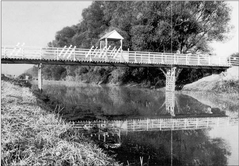
29. kép. Az “Andaui-híd” és szabadtéri múzeum / Die “Brücke von Andau” und das Freilichtmuseum
