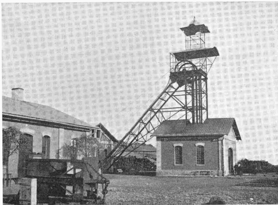
A rákosi szállító-akna kötélkorong-állványa.
