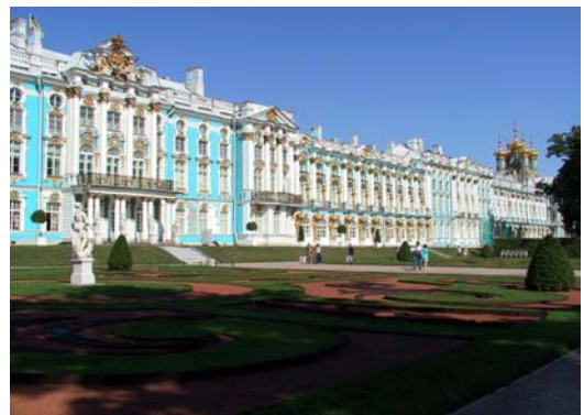
167. Kerti homlokzat a felújítás után
