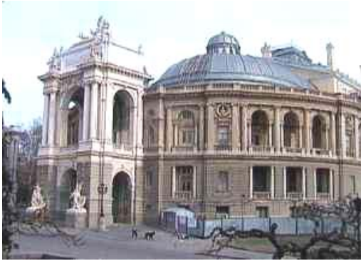
Od-143. A bejárati torony
