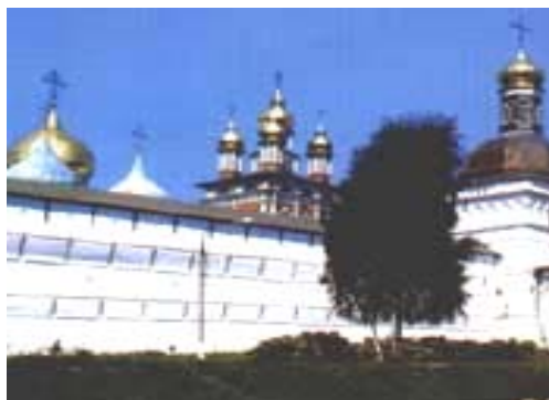
Za-118. A kolostor épülete
