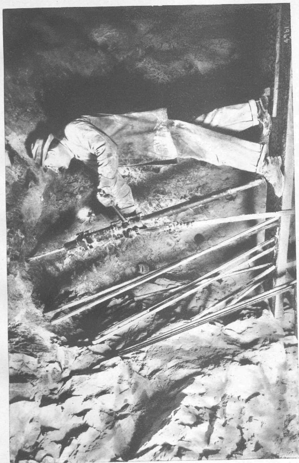
Ingersoll-féle elektropneumatikus fúrókalapács a nagybányai vörösvízi bányában.
