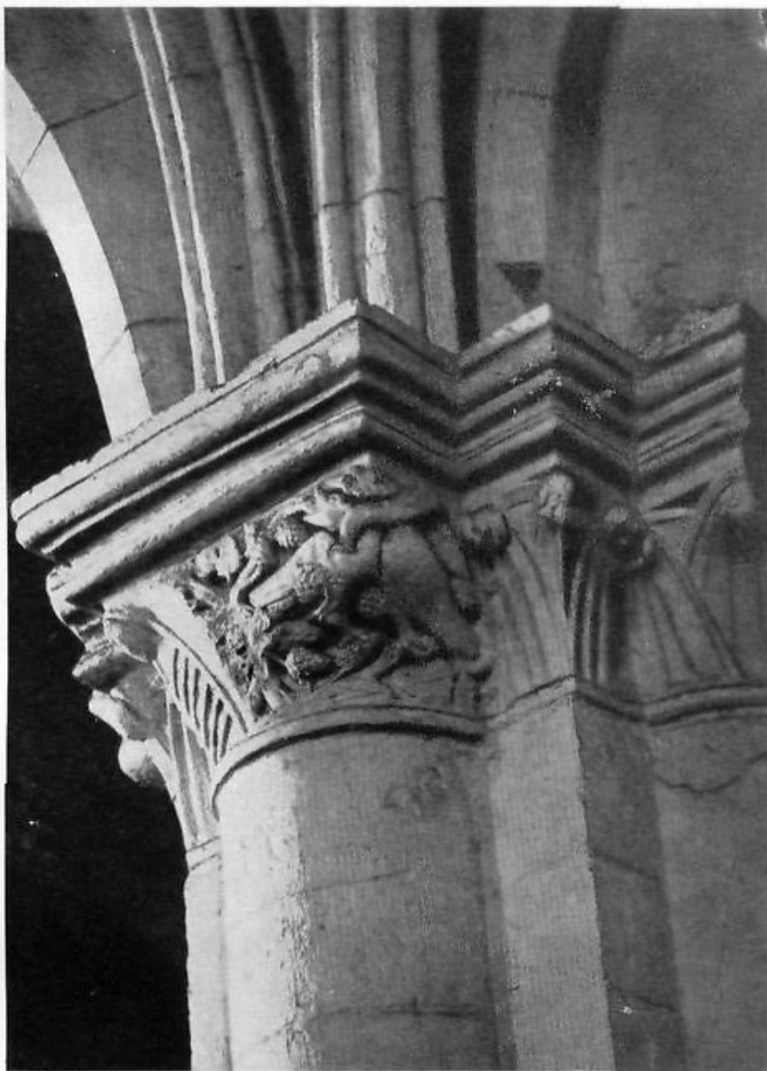
170. kép. A 29. sz. pillérfő helyreállítás előtti állapota
