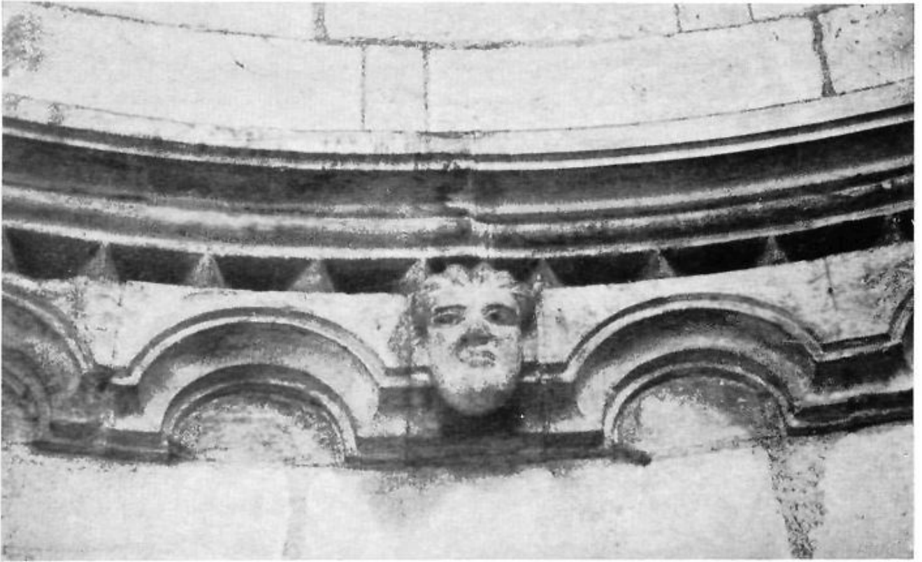
118. kép. A déli mellékszentély belső párkánya
