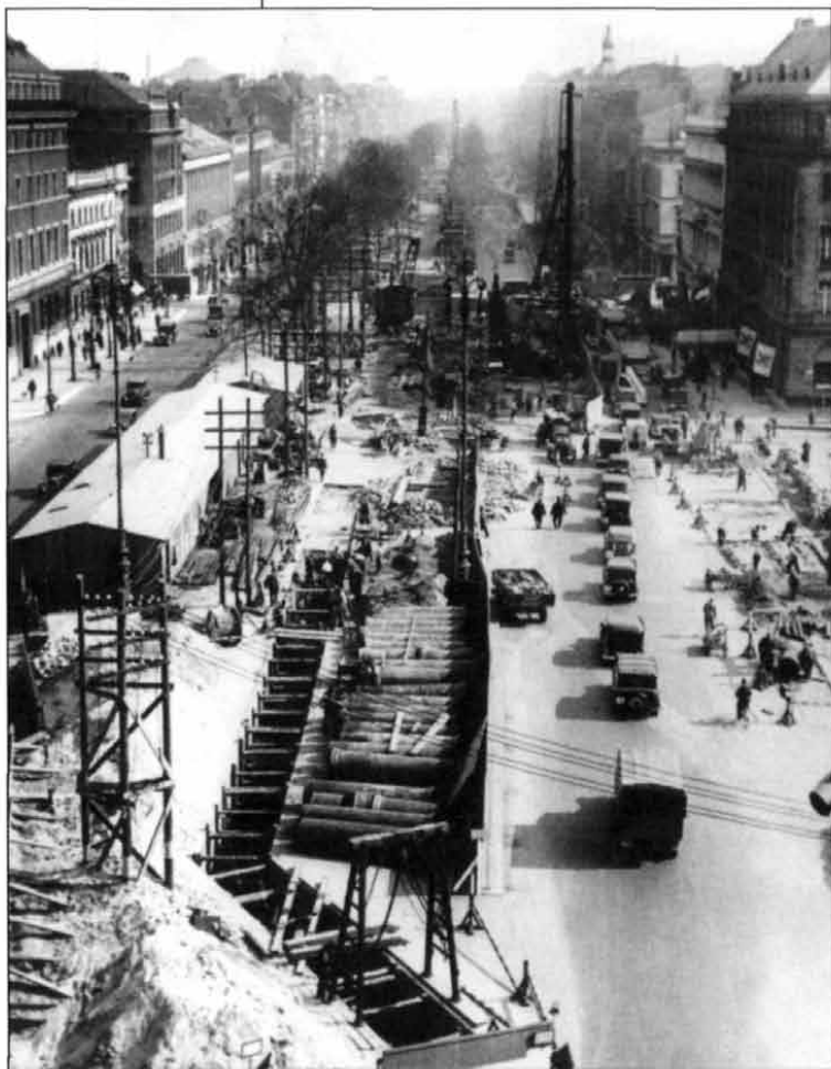
Blick über „die Linden“ Richtung Osten beim Bau der Nord-Süd-Bahn (links hinten: Schulte-Haus), 1935 (Ullstein- Bilderdienst)
