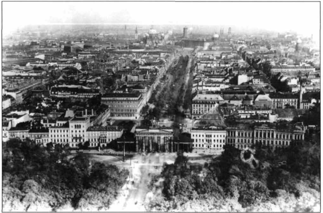
Brandenburger Tor (dahinter: Pariser Platz, links dahinter: Einmündung der Neuen Wilhelmstraße mit Schulte-Haus), Luftaufnahme, um 1925 (Archiv für Kunst und Geschichte)
