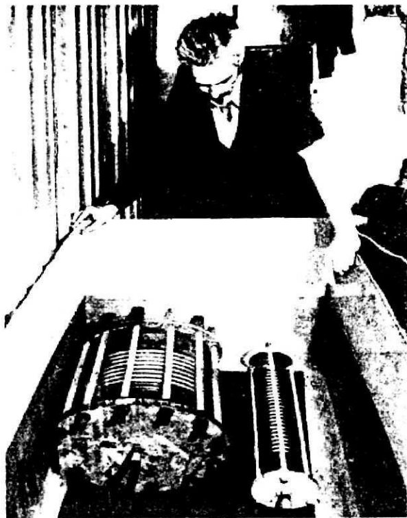
18. ábra A kompenzátorok buborékos tömörség vizsgálata
