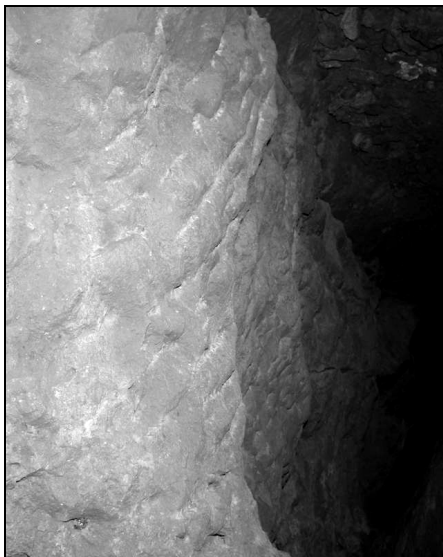
3. kép. Bányászékek nyomai a vágat oldalában.
