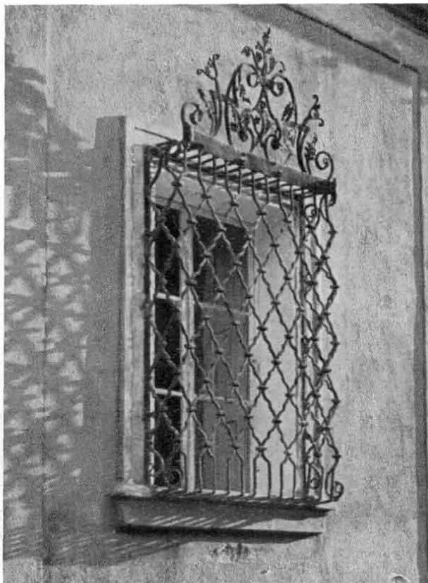
160. WASTAGH GYÖRGY UTCA 1. ABLAKRÁCS AZ OLDALHOMLOKZATRÓL
