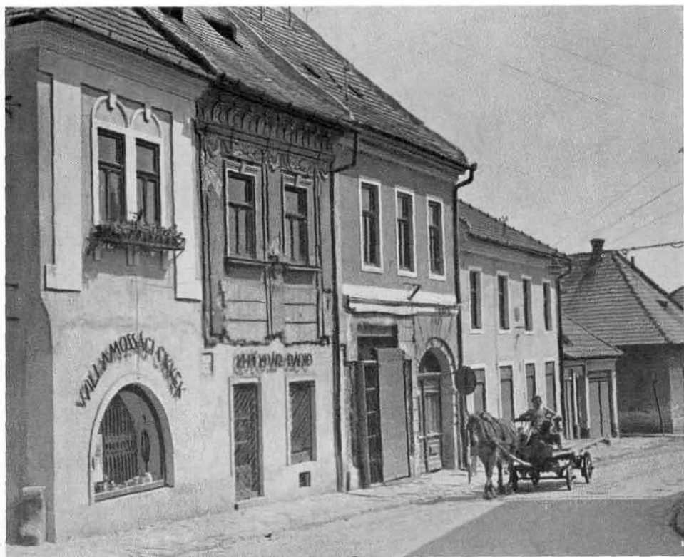
63. A DUMTSA JENŐ UTCA TORKOLATA A TÉR FELŐL, A 2—6. SZ. HÁZAK EGYÜTTESÉVEL
