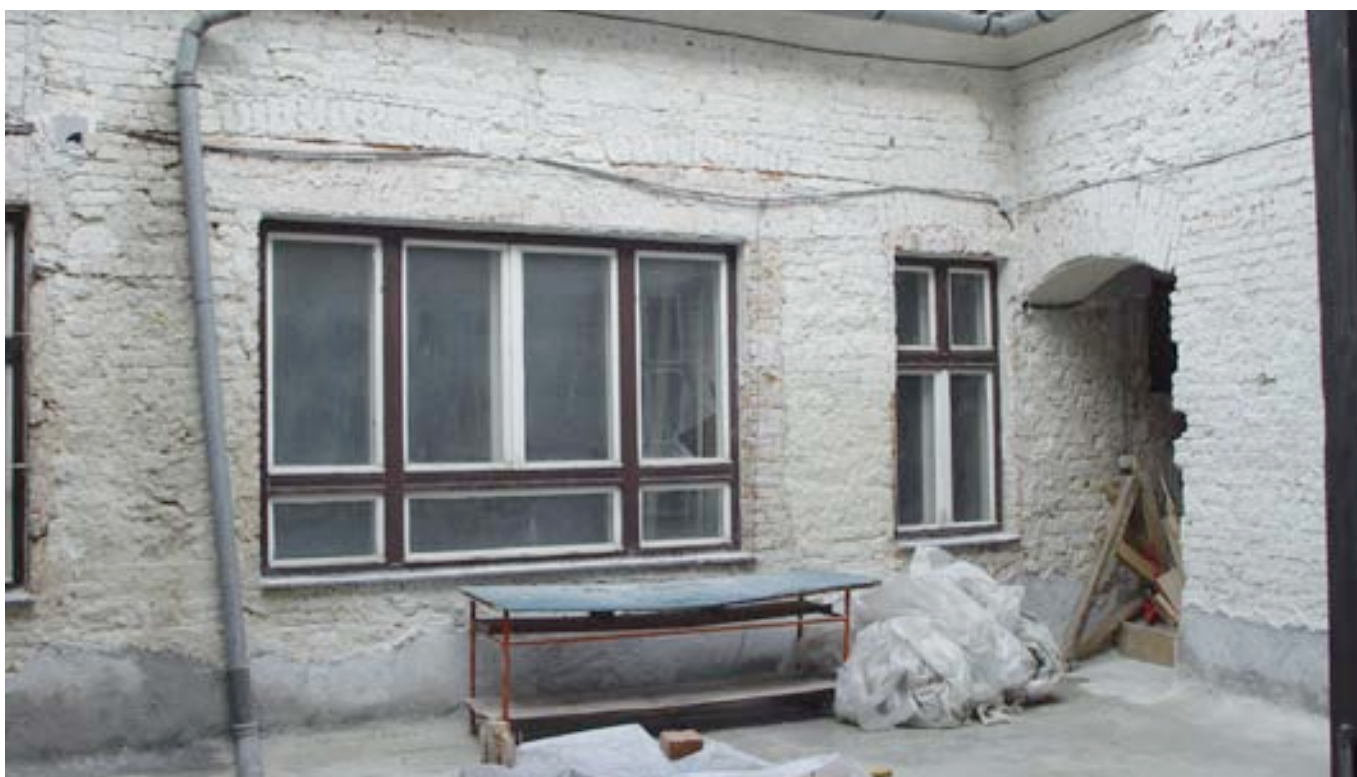
Az átrium az átépítés előtt
