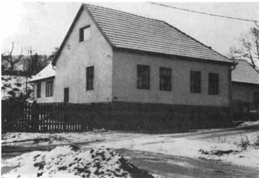
A régi óvoda, Solymáron, télen
