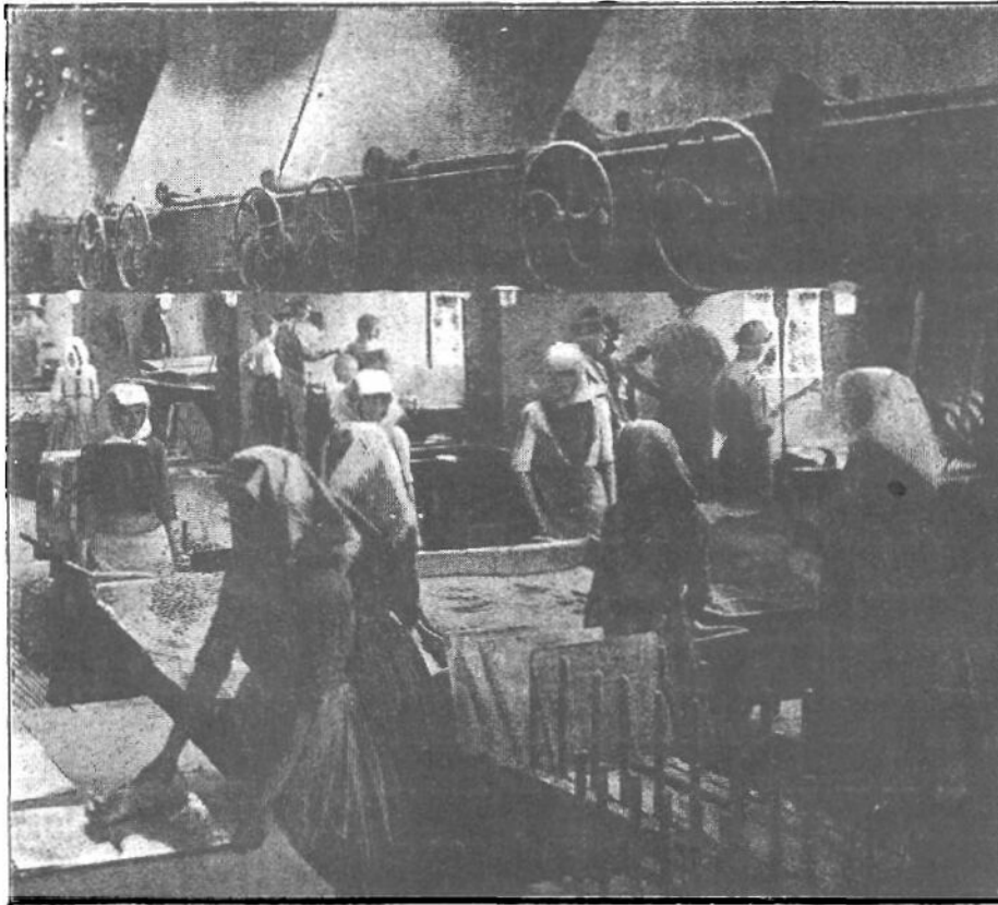
64. ábra. A rimamurány-salgótarjáni vasmű-részvénytársaság nádasdi lemezgyárának ónozó műhelye.
