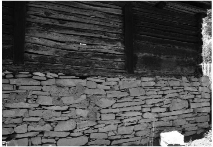
66. ábra Zsilipelt és csapolt boronafal egyazon épületben
