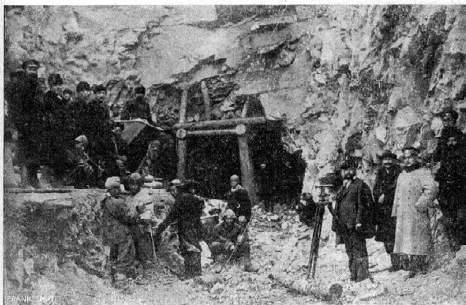
Az alagútépítés kezdetén.
