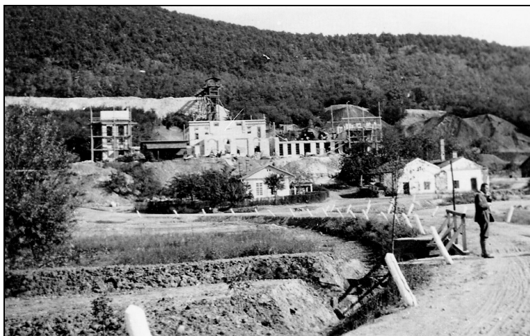
21. kép. Az ércelőkészítő mű építése 1928-ban.
