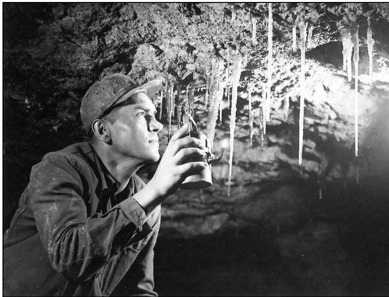
51. kép. A felhagyott fejtési üregekben másodlagos ércképződmény (rézszulfát) cseppkő alakban válik ki, 1954.
