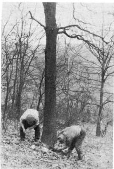
2. kép. A fa döntése kézfűrésszel
