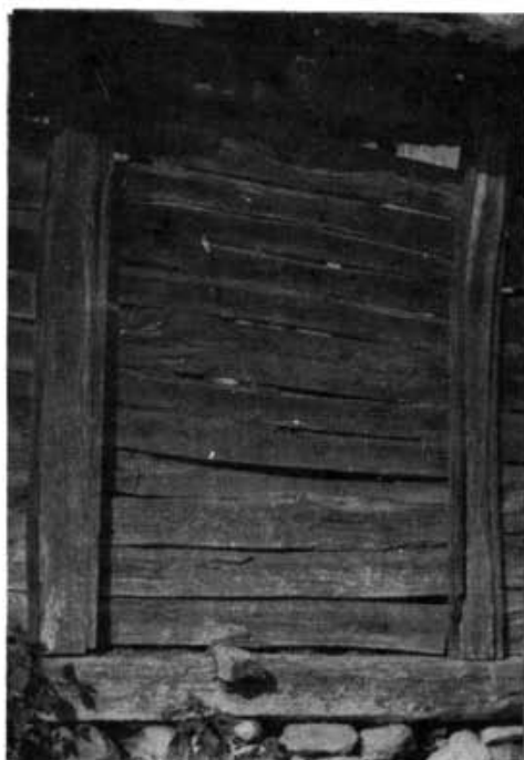
12. kép. Zsilipelt fal részlete, Vágáshuta. Gunda B. felv.
