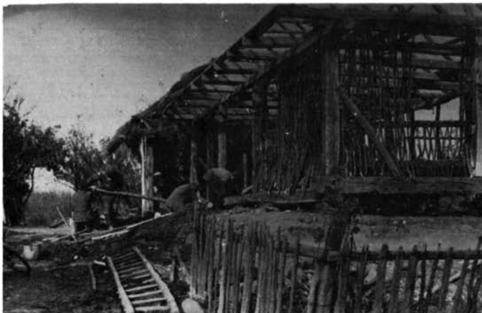
13. kép. Talpas-vázás sövényfalú ház építés közben, Fony. Bellon T. felv.
