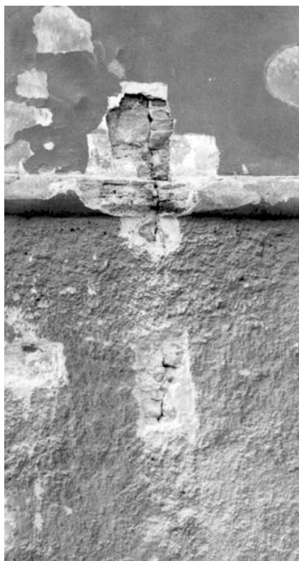
36. Falelválás a délkeleti homlokzaton. Kovács András felvétele.
