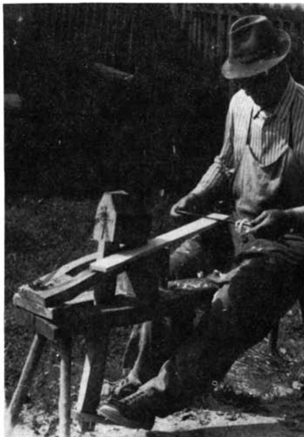
1. kép. Munka a faragószéken kétnyelű késsel. Petercsák Tivadar felvétele
