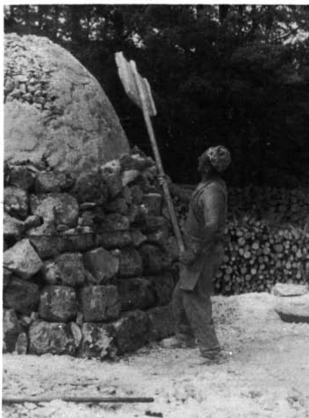
11. kép. A mészégető boglya fedése lángossal. Petersák Tivadar felv.
