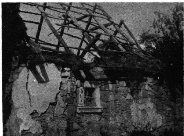
17. kép: Szarufás tetőszerkezet a pusztuló Török-féle házban
