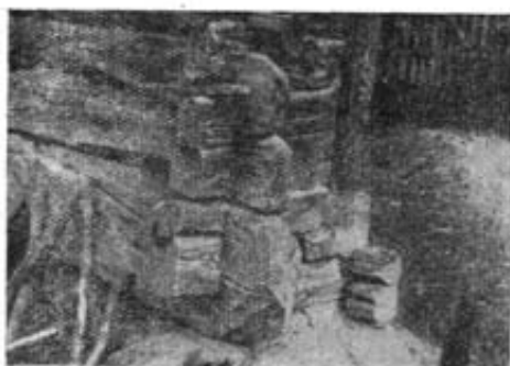
9. ábra. Vályus csapolási mód. Böde.
