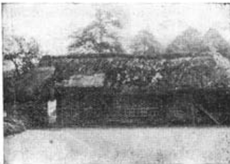
13. ábra. Vályus csapolású boronafal és lábas megoldás. Márokföld.
