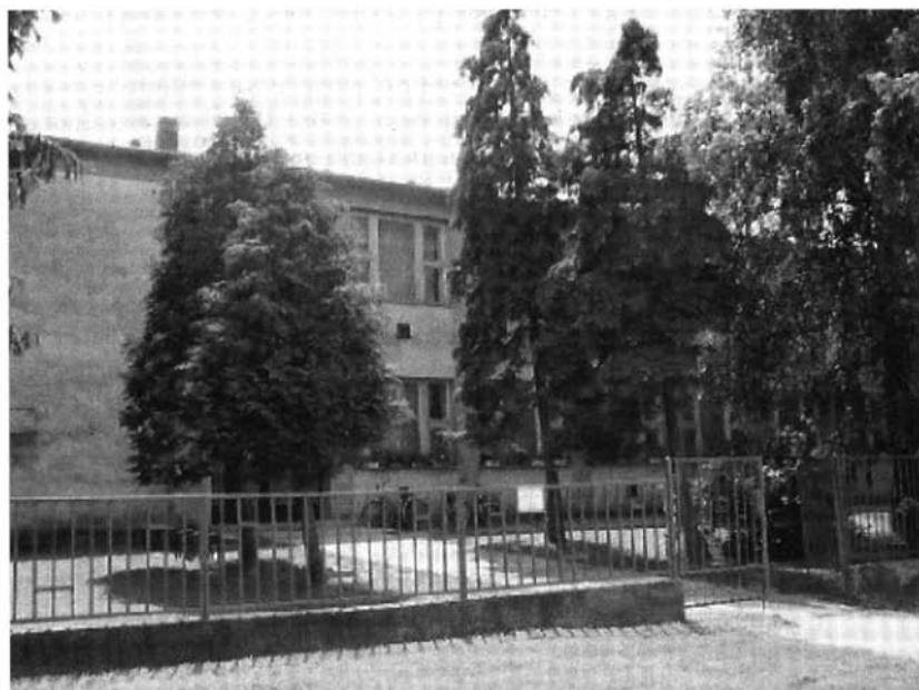
Az általános iskola épülete
