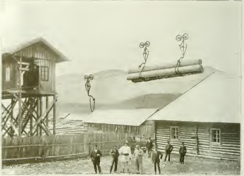
Einfahrtseite der Drathseilbahnstation Csimpa des Sägewerkes Firma Polacsek & Scheiber.
