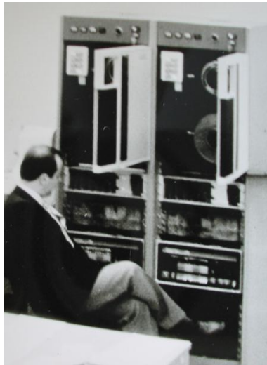
Girozentrale Wien 1971/72, Multiplex 80
