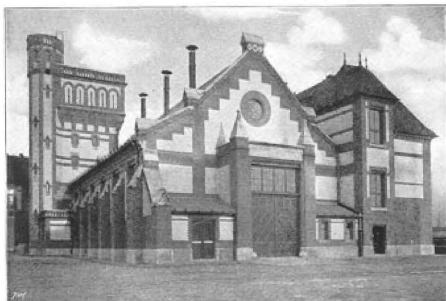
Mezőgazdasági géptani épület
