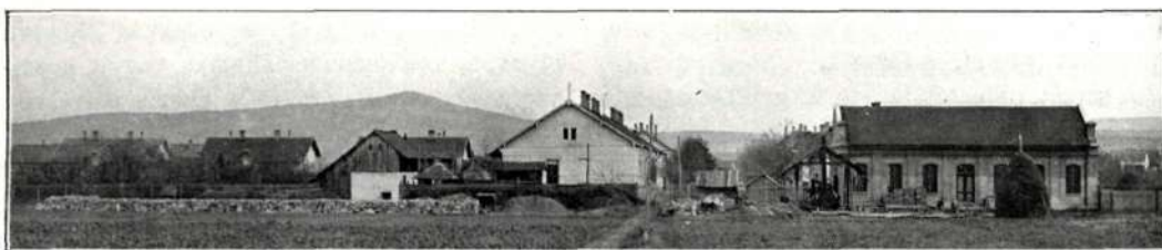
78. kép. Szivattyúház és tisztítalakok.
