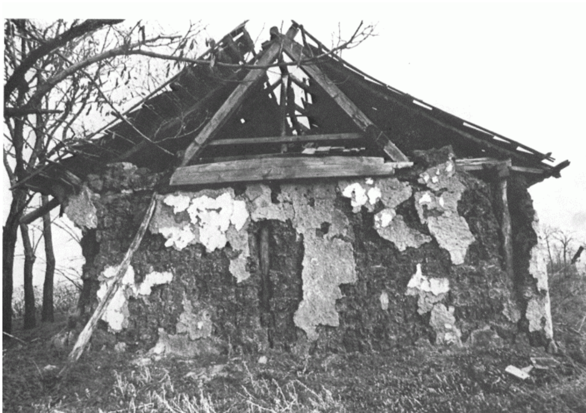
A széteső épületből előtűnik a „cölöpszerkezet” és a tetőszerkezet (IX. dűlő Tódor Nagy József tanyája)
