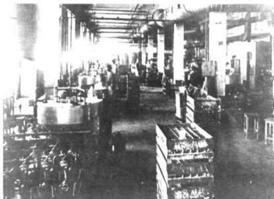
Izzólámpagyártás 24 fejű szivattyúautomatákkal, 1920-as évek.
