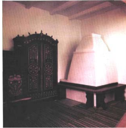
Bild 418: Backofen aus Reisiggerüst und Lehm gebaut
