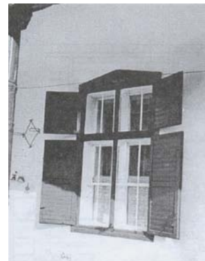
Bild 395: Gangfenster eines Pfeilerhauses mit Klappläden 1/3 Oberfenster, 2/3 Unterfenster
