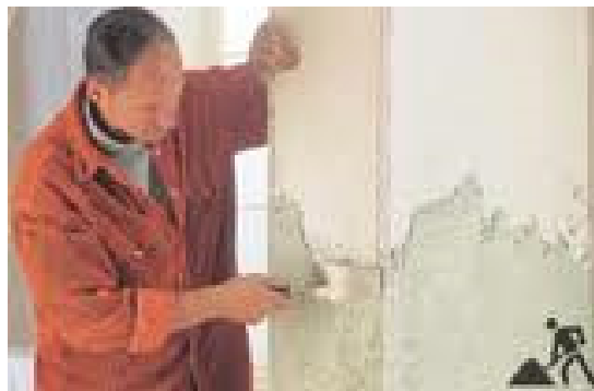
Bild 427: Verputzen der Wand
