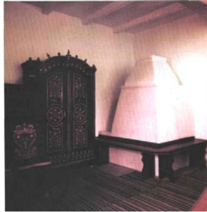
Bild 418: Backofen aus Reisiggerüst und Lehm gebaut
