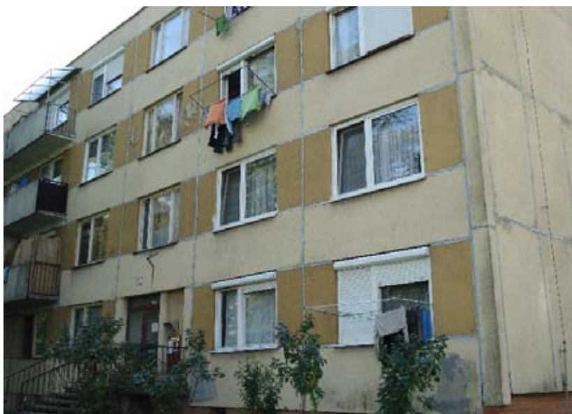
47. Felújításra váró panelház (Észak-Komárom)
