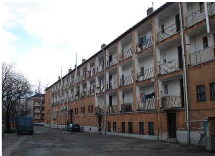
44. Egy felújításra váró sorház hátsó udvara (Dél-Komárom)
