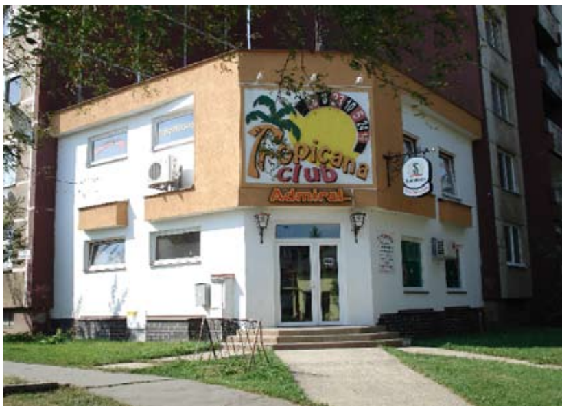
43. Panelházba beillesztett szórakozóhely (Észak-Komárom)
