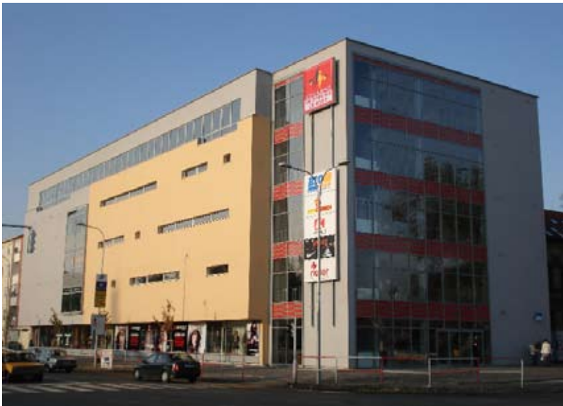
18. A 2006 őszén megnyílt Komárno Shopping Center
