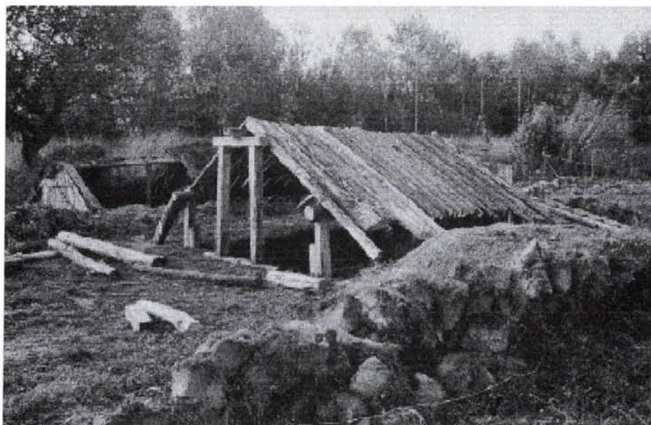
11. kép. Új verem építése Szalafőn a beszakadt régi helyett (Kottmayer Tibor felvétele, 1995.) – 11. Abb. Die Bauarbeiten einer neuen Grube in Szalafő, die die alte, eingestürzte ersetzen mag (Aufnahme von Tibor Kottmayer, 1995.)
