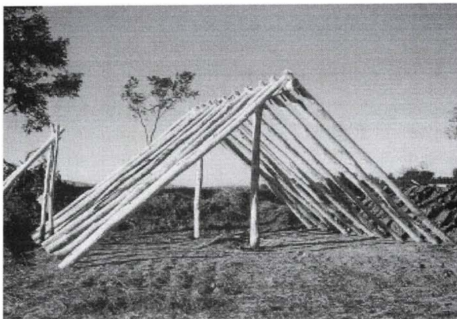
29. kép. A veremház szerkezetének felállítása (Sabján Tibor felvételei, 1997.) – 29. Abb. Aufbauarbeiten der Struktur des Grubenhauses (Aufnahmen von Tibor Sabján, 1997.)
