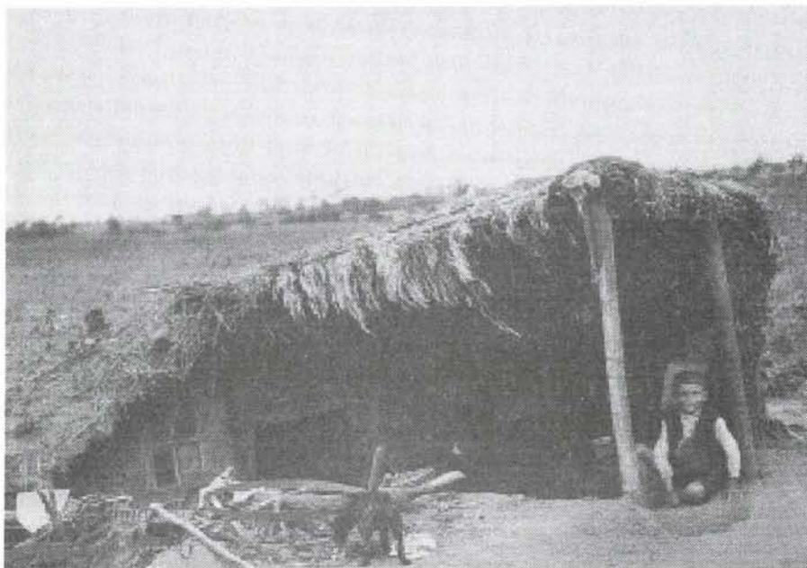
20. kép. Földház végbejárattal és védőtetővel Sóstóhegyen (Gönyey S. felvétele, 1927.) 20. Abb. Erdhaus mit Endeingang und Schutzdach in Sóstóhegy (S. Gönyey, Aufnahme aus 1927.)
