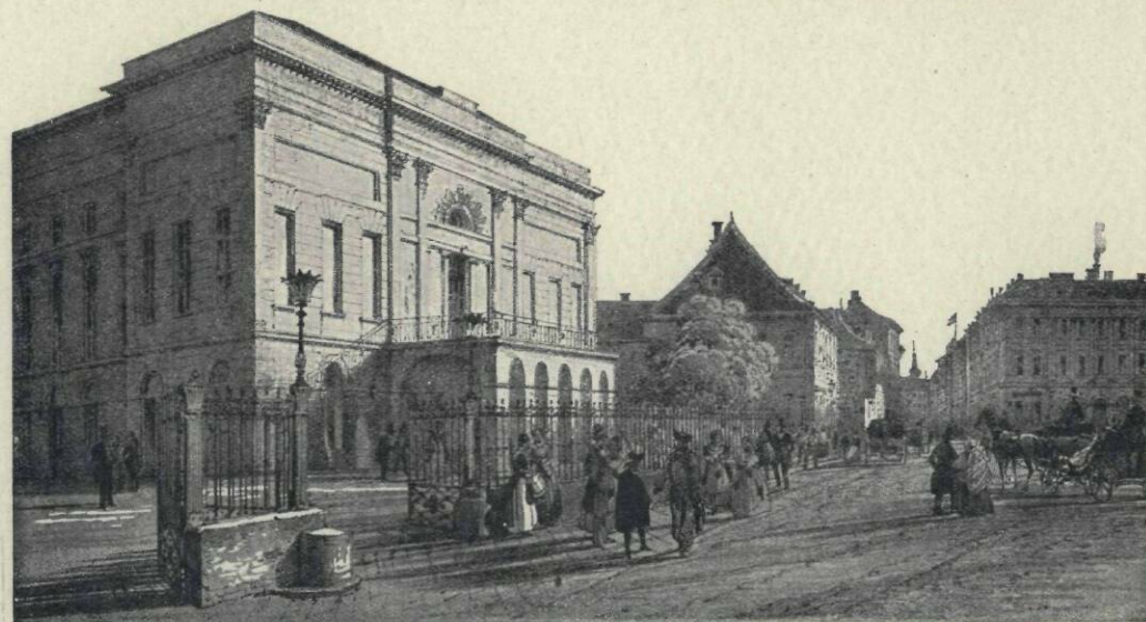
A Nemzeti Színház régi épülete.
