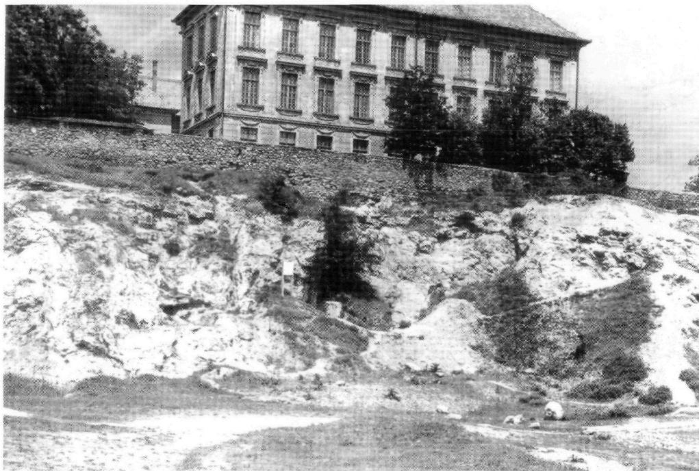
Fig. 28. Excavation of Tata-Porhanyóbánya (archive photo)
